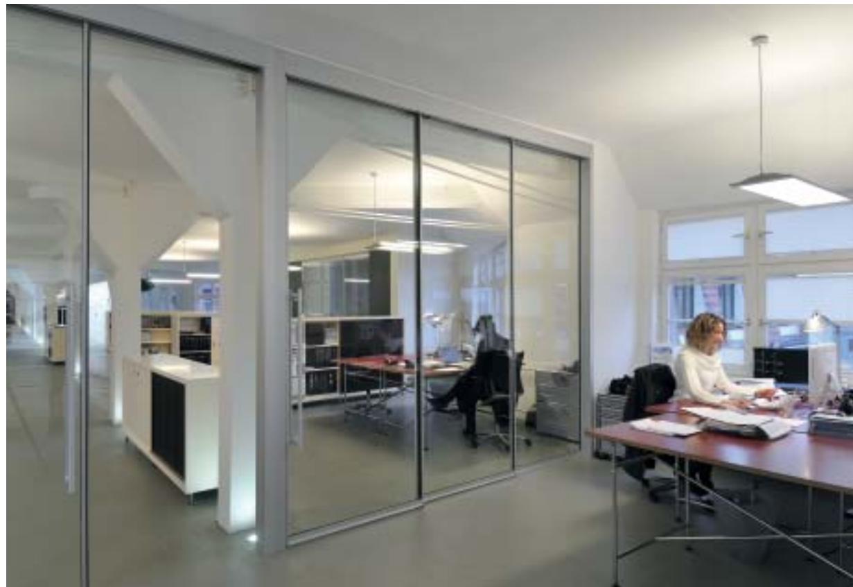
Die Glastrennwände schirmen zwar akustisch ab, stören aber nicht die Idee des offenen Büros. The glass partition walls do not compromise the open office conception.
